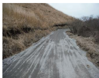
村山牧野組合 (鉄鋼スラグ舗装)
