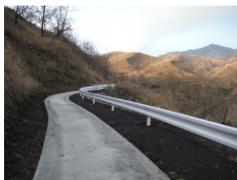
白川牧野組合(東工区) (コンクリート舗装)
